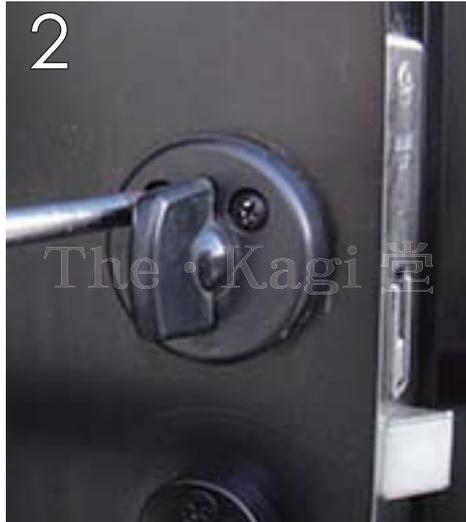
2 まずは、室外側シリンダーを押さえながら、室内側サムターンの固定ネジ 2ヶ所をプラスドライバーで外します。
