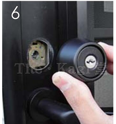
6 新しいシリンダーと交換し、サムターンを付け直します。
