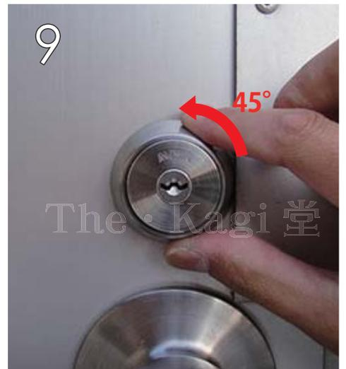
9 シリンダーが収まったら、左に 45 度傾け、【4】のシリンダーの固定ネジを締め直して作業完了です。
