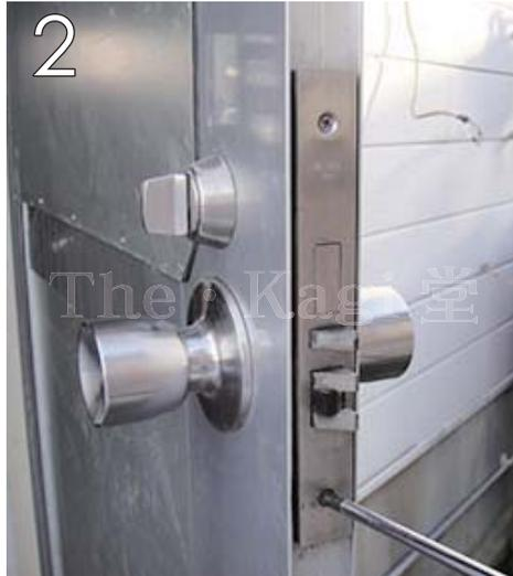
2 扉側面のプレートを固定しているネジ 2ヶ所をプラスドライバーで外します。
