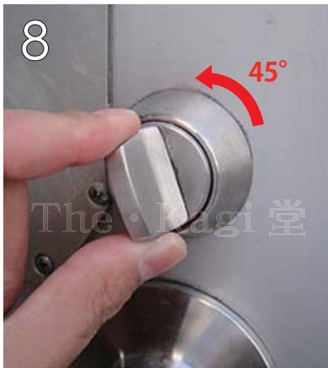
8 同時に室内サムターンをシリンダーとは逆に左に 45 度傾けると、シリンダーが押し込みやすくなります。
