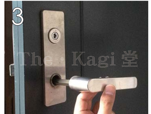
3 先程のネジが外れると、室内側・室外側のハンドルを引き抜けます。
