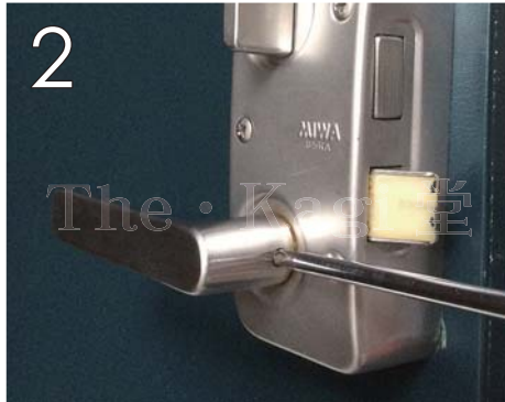
2 まずは室内側ハンドルの根本にあるネジをプラスドライバーで外します。
