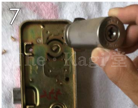
7 シリンダーが外れますので、新しいシリンダーを取り付け、あとは逆の手順でドアに戻して完了です。
