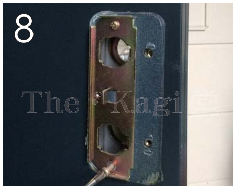
8 本体ごと取替える際は、室内側ケースを外した下にある、受座金具のネジ2ヶ所を外します。
