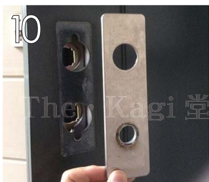
10 これで室外側のプレートも外れます。あとは、逆の手順で本体を交換して作業完了です。
