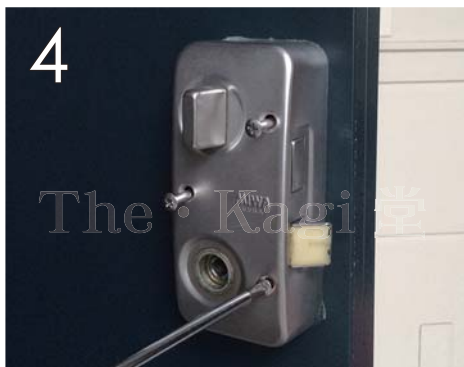
4 次に室内側ケース本体の表面に見えるネジ3ヶ所を外します。
