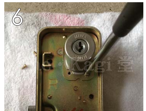
6 外した本体を裏返して、シリンダーを固定しているネジ4ヶ所を外します。
