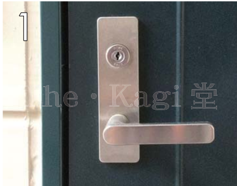
1 RA タイプのシリンダー交換を行います。
