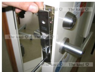
2. フロントの上下2カ所に見えているネジを外し、フロント部分を外します。
