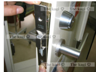
6. これまでと逆の手順で、まずはシリンダー入れ、固定ピンを差し込み、外したフロントをビスで取り付けします。
