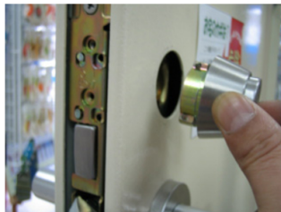
4. 2カ所のピンが抜けるとシリンダーが外れます。
