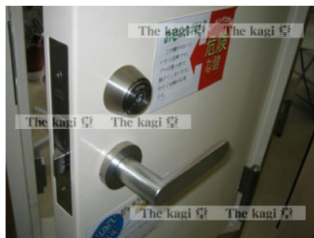
1. ドアを開いて、側面にあるフロント(金属プレート)を確認します。
