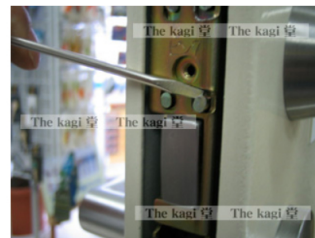
3. 中を見ると、4カ所の差し込みタイプの固定ピン(金属の棒)が差し込んであります。このピンの室外側2カ所(赤丸印)を引き抜きます。マイナスドライバーなどを使うと簡単です。
