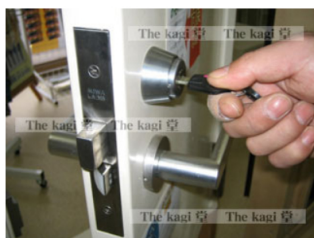
7. 商品に付属のキーを差して動作を確認します。これで作業完了です。比較的簡単に交換できますが、困ったときは、お気軽にご連絡ください。
