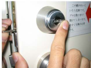
5. 新しいシリンダーを取り付けていきます。本内容では「MUL-T-LOCK(マルチロック)」の商品ですが、他社の商品も手順は同じです。
